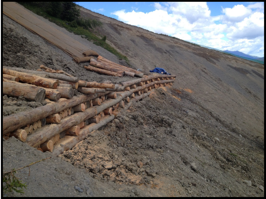
Esempio di realizzazione di briglie in legname e pietrame
