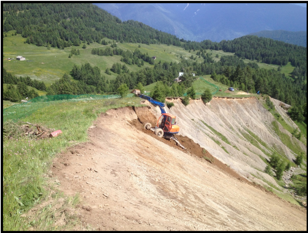
Esempio di scoronamento e regolarizzazione del versante
