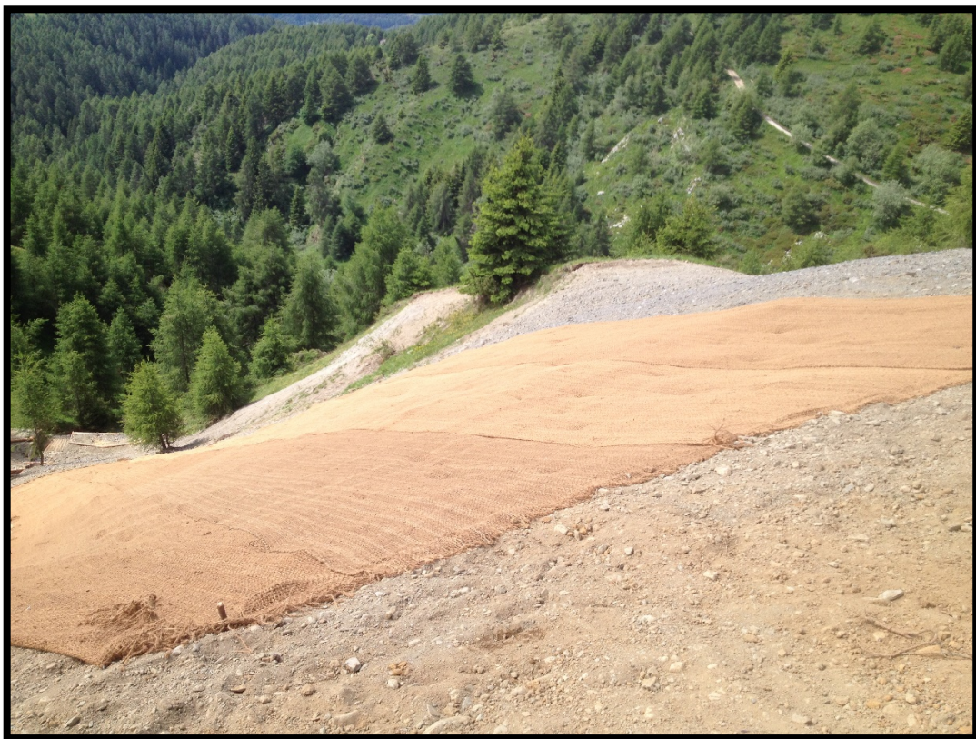
Esempio di posa di biostuoia in cocco
